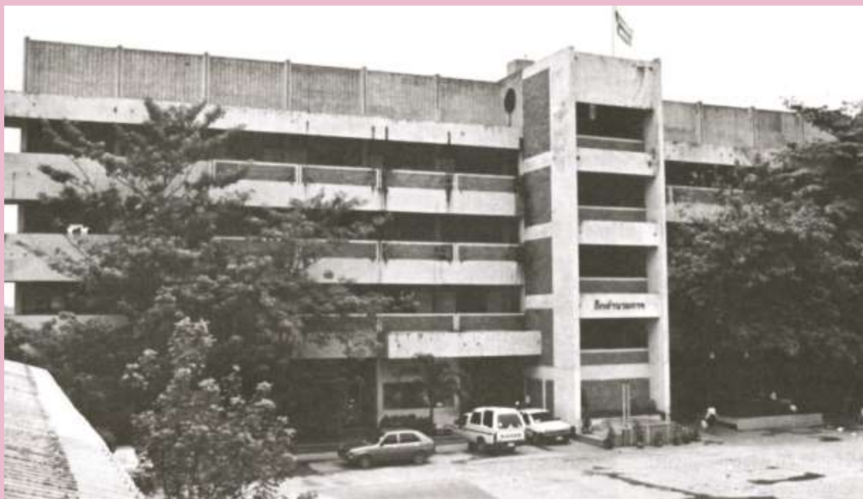
อาคารเรียนสร้างใหม่แทนอาคารเก่าซึ่งเดิมเป็นเรือนไม้
